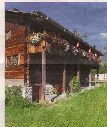
Das Wohnhaus von Bruder Klaus in Flüeli.
